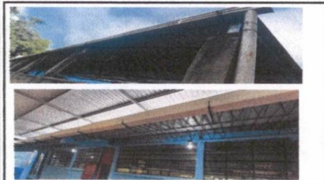
Foto 5: Sustitución de canal de pvc
