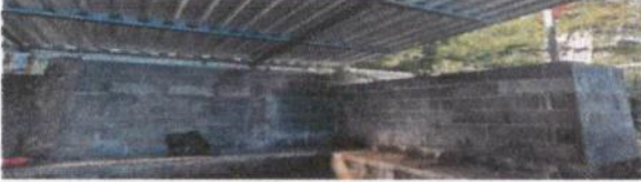
Foto 7: Sustitución de 12 M2 de muro perimetral de block, malla galvanizada, soleras intermedias y columnas
