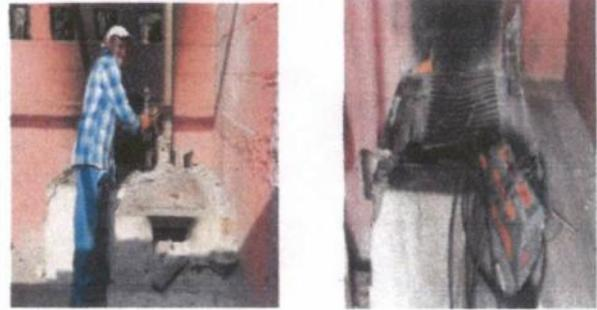
Foto 10: Reparación de estufa rural (loza de hornilla). Mantenimiento de plancha de estufa rural.
