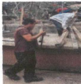
Foto 2: Sustitución de 49 M2 de lámina y estructura por lamina troquelada y estructura de metal
