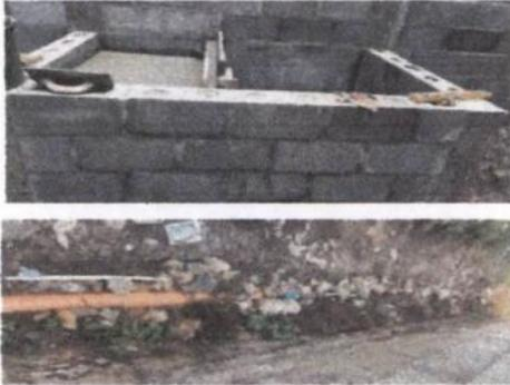
Foto 9: Sustitución de pila de concreto de largo 2m, ancho 1m, altura 1m; incluyendo accesorios. Colocación 20 MI de tubería de PVC línea principal de aguas neras y 20 ML tubería de agua potable
