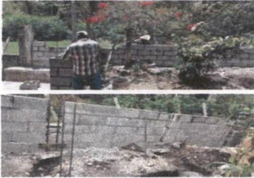
Foto 7: Sustitución de 12 M2 de muro perimetral de block, malla galvanizada, soleras intermedias y columnas
