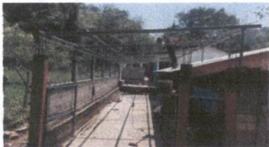
Foto 1: Ampliación de 192 m2 de lámina troquelada y estructura de metal en patio del establecimiento
