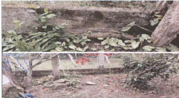
Foto 7: Sustitución de 12 M2 de muro perimetral de block, malla galvanizada, soleras intermedias y columnas
