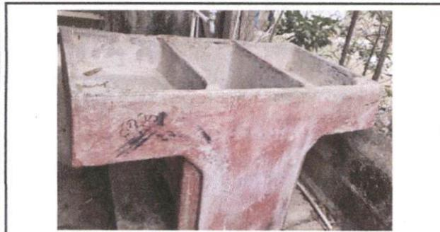
Foto 9: Sustitución de pila de concreto de largo 2m, ancho 1m, altura 1m; incluyendo accesorios. Colocación 20 MI de tubería de PVC línea principal de aguas negras y 20 ML tubería de agua potable
