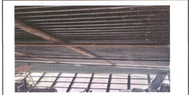
Foto 2: Sustitución de 49 M2 de lámina y estructura por lamina troquelada y estructura de metal
