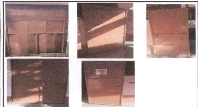
Foto 3: Mantenimiento a estructura de 5 puertas (lijado, cambio de tubo, cepillado, sujeciones, aplicación de pintura)
