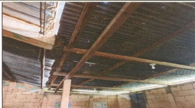
Foto 2: Sustitución de estructura de madera por estructura metálica.
