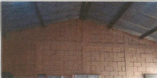
Foto1: Sustitución de lámina por lámina canalada.
