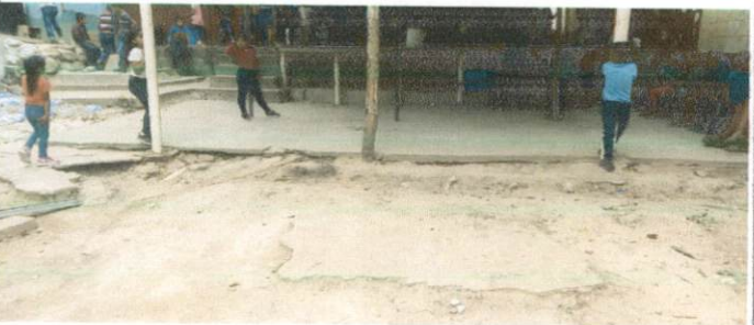
Foto 5: Piso, reparación de piso de torta de concreto.
