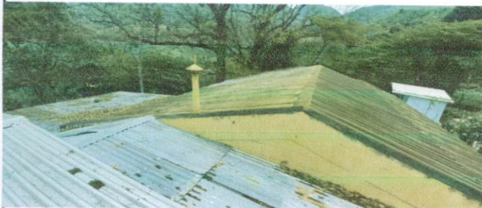
Foto 1: Cubierta de lámina, sustitución de lámina por lámina troquelada.
