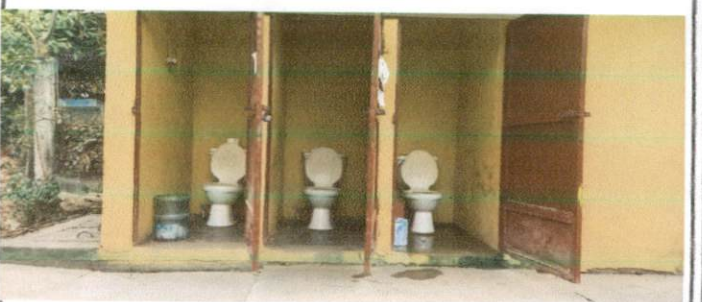
Foto 6: Servicios sanitarios y sus accesorios, sustitución de inodoros.
