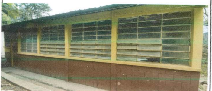
Foto 4: Mantenimiento de barandas, sustitución de balcones.
