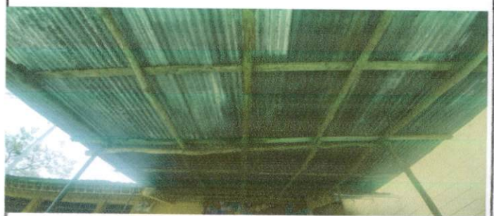
Foto 2: Estructura de techo, sustitución de estructura de soporte de madera por metal.
