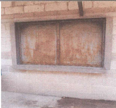
Foto 3: Reparación y pintura de ventanas
