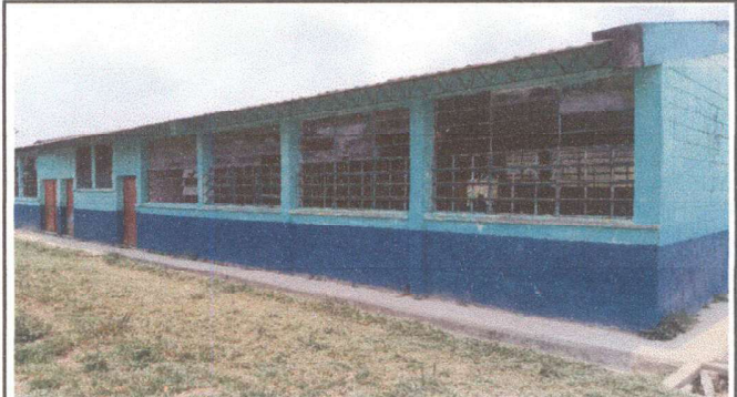
Foto 4: Sustición de balcones de metal
