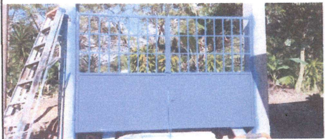
Foto 4: Sustitución de portón.
