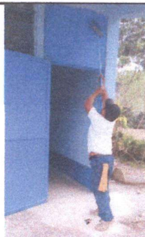
Foto 5: Mantenimiento de puertas (lujado, cepillado y pintado)
