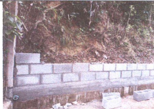
Foto 2: Reparación de muro perimetral izquierdo
