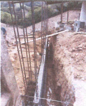
Foto 3: Reparación de muro perimetral lado derecho.
