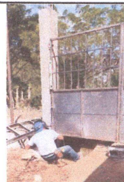
Foto 4: Sustitución de portón.
