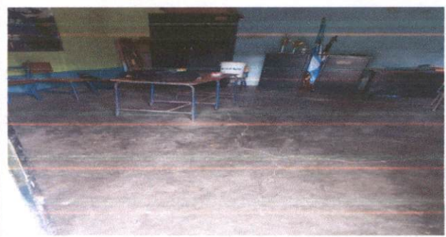
Sustitución de torta de cemento por piso de granito
