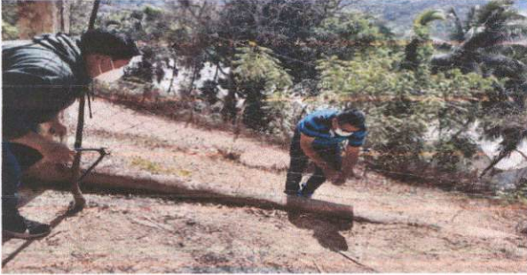
Reparación de circulación de muro perimetral
