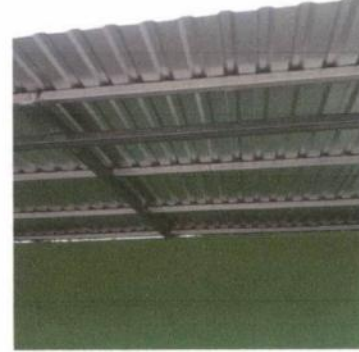
Foto 2: Techo de escenario ya instalado.
