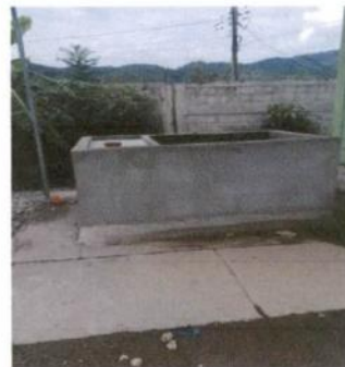
Foto 6: Pila del patio ya reparada.
