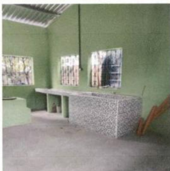
Foto 3: Pila de cocina ya reparada.
