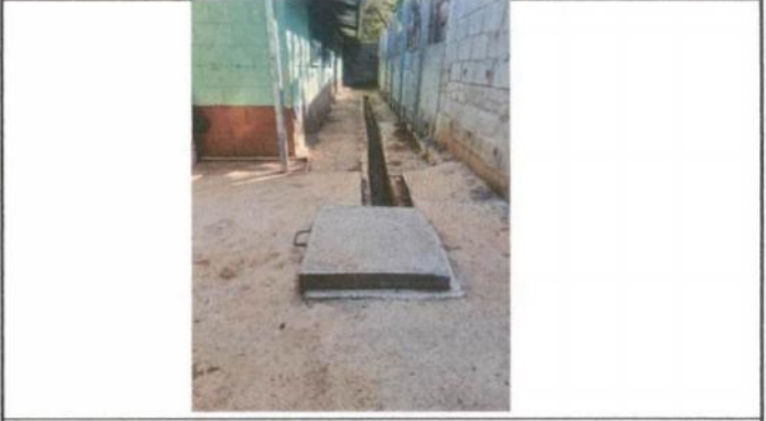
Foto 4: Reparación red de drenaje para evitar empozamiento de agua por lluvias.
