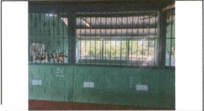
Foto 1: Sustitución de ventanales dañados para ventilación en aula para ingreso correcto de iluminación.
