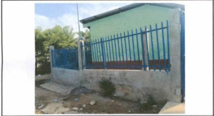
Foto 3: Reparación y extensión de muro perimetral de establecimiento.
