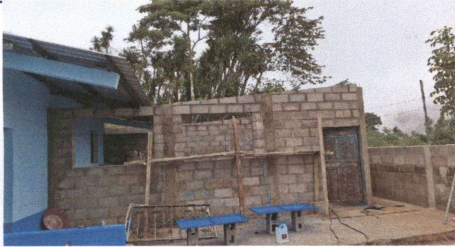
Foto 1: Anexo; Construcción de aula
