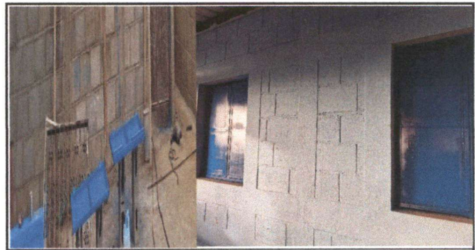
Foto 6: nexa; aplicaion de pintura en ventanas
