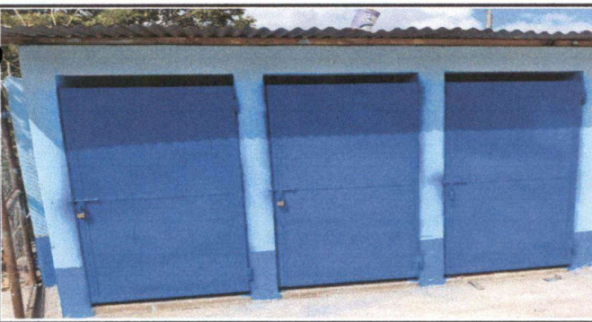
Foto 5: Anexo; Aplicación de pintua en puertas
