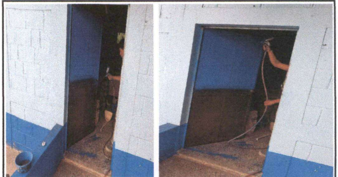
Foto 2: Anexo; Aplicación de pintura a puerta
