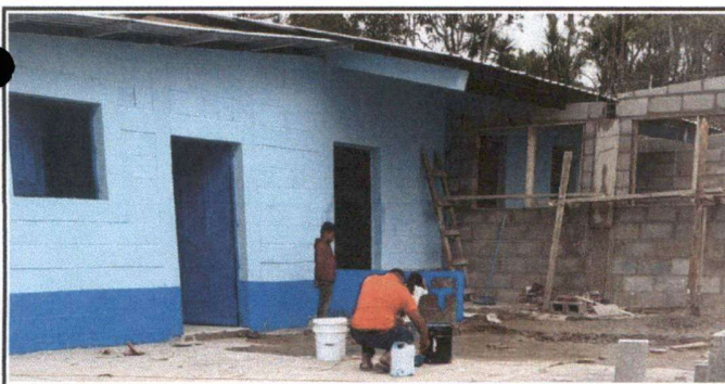
Foto 5: Pintura en muros exteriores e interiores
