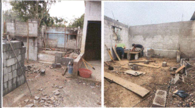
Foto1: Reparación de cocina
