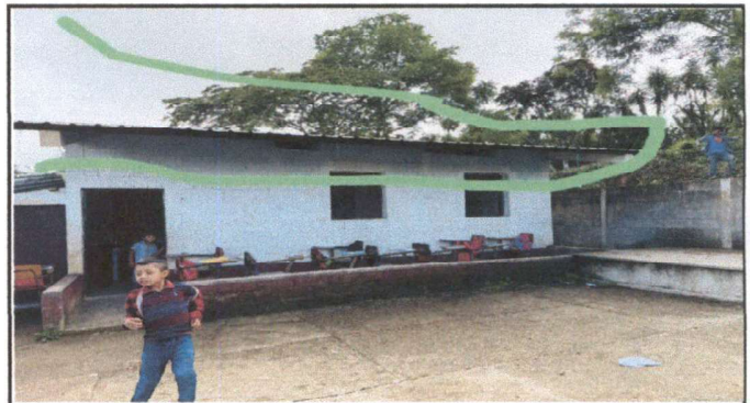
Foto 4: Instalación de canales y bajada de agua pluvial
