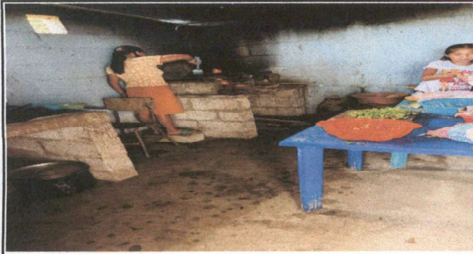
Foto 1: Reparación de cocina
