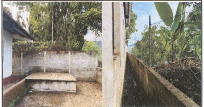
Foto 2: Reparación de Muro perimetral
