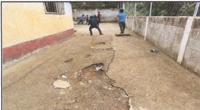
Foto 3: Reparación de losa de patio
