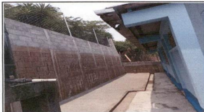
Foto 3: FUNDICIÓN DE LOSA DE PATIO
