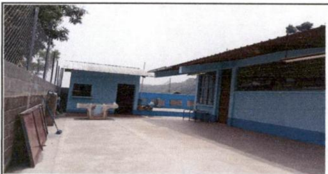
Foto 5: FUNDICIÓN DE LOSA DE PATIO
