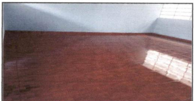
Foto 6: INSTALACIÓN DE PISO
