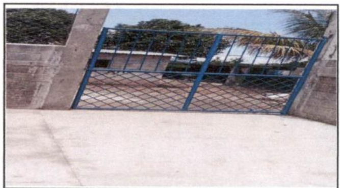
Foto 4: SUSTITUCIÓN DE PORTON
