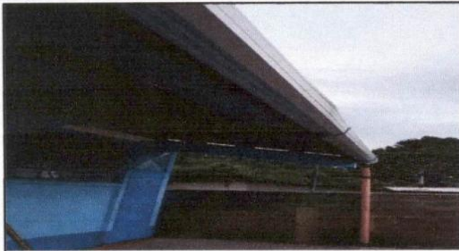
Foto 1: INSTALACIÓN DE CANALES Y BAJDA DE AGUA PLUVIAL
