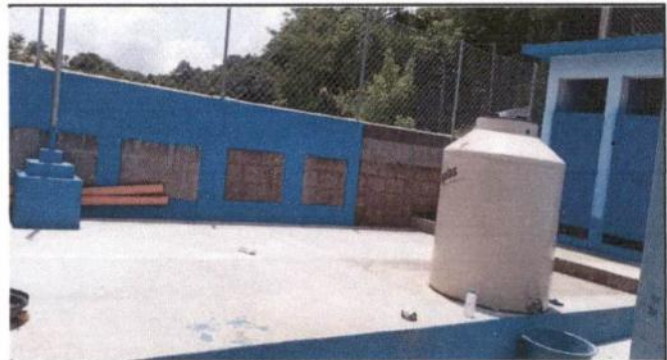
Foto 4: FUNDICION DE LOSA DE PATIO
