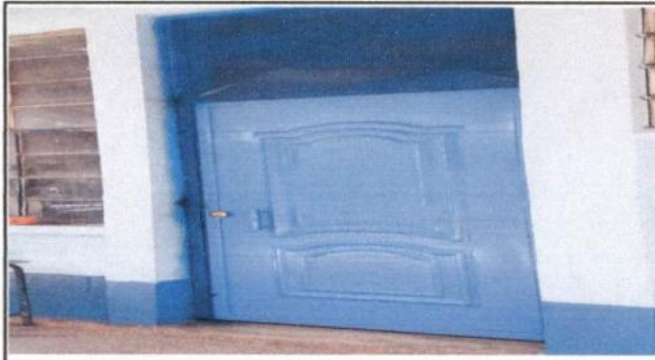
Foto 1: SUSTITUCIÓN DE PUERTA
