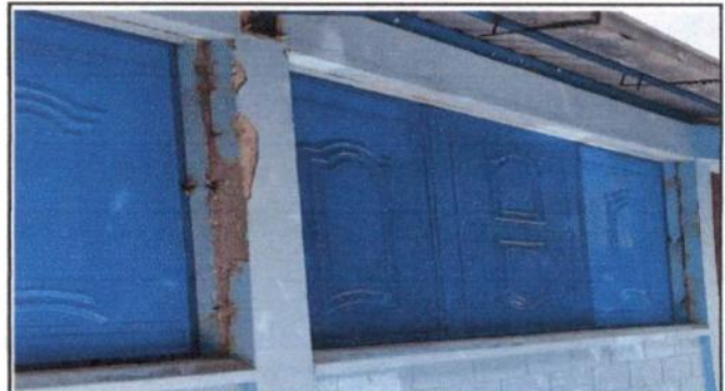
Foto 2: SUSTITUCIÓN DE VENTANA
