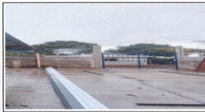
Foto 5: FUNDICIÓN DE LOSA DE PATIO
