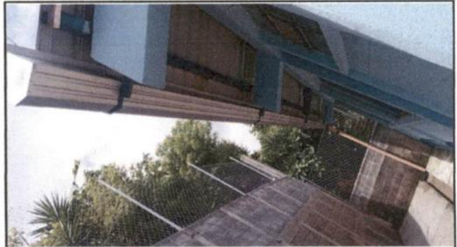
Foto 2: CANALES Y BAJDA DE AGUA PLUVIA
