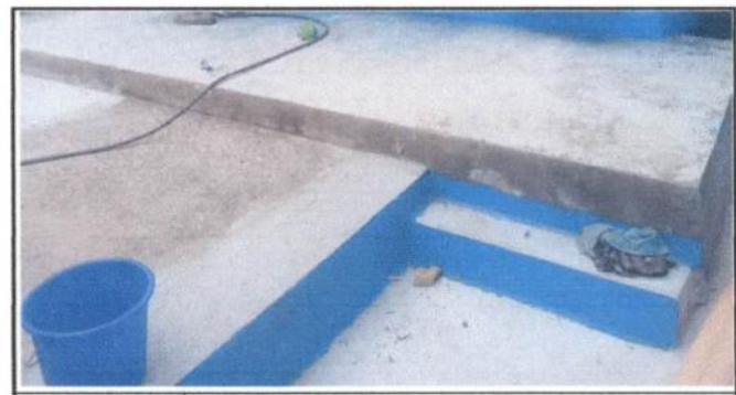
Foto 6: FUNDICIÓN DE LOS DE PATIO
