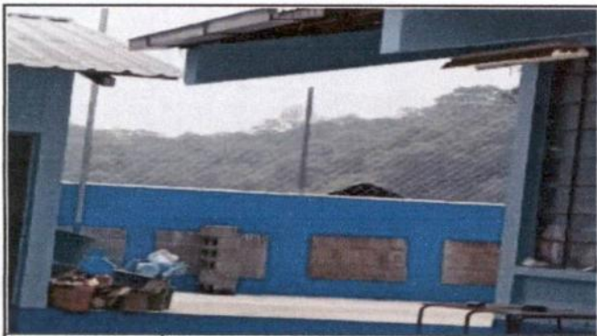
Foto 3: REPARACIÓN DE MURO PERIMETRAL
