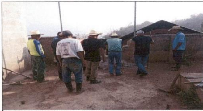
Foto 3: REPARACIÓN DE MURO PERIMETRAL
