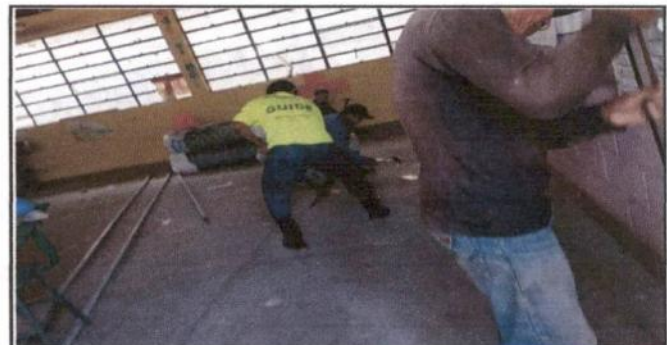
Foto 6: PREPARACIÓN PARA INSTALACIÓN DE PISO
