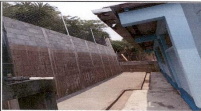
Foto 3: FUNDICIÓN DE LOSA DE PATIO
