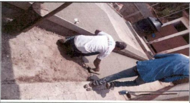
Foto 5: FUNDICIÓN DE LOSA DE PATIO
