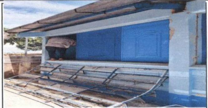
Foto 2: SUSTITUCIÓN DE VENTANA
