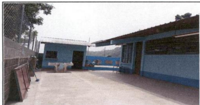
Foto 5: FUNDICIÓN DE LOSA DE PATIO
