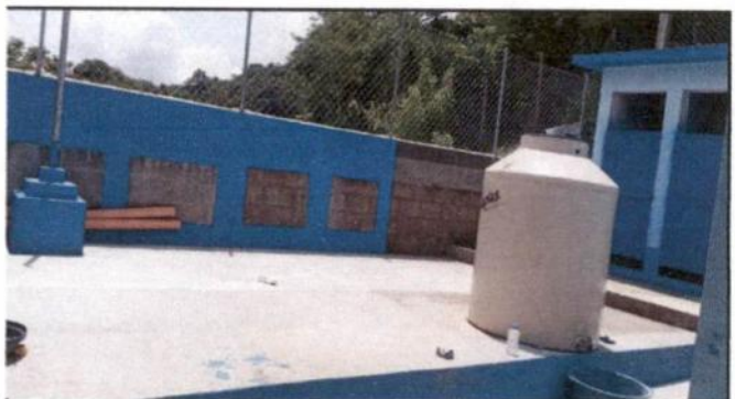
Foto 4: FUNDICION DE LOSA DE PATIO
