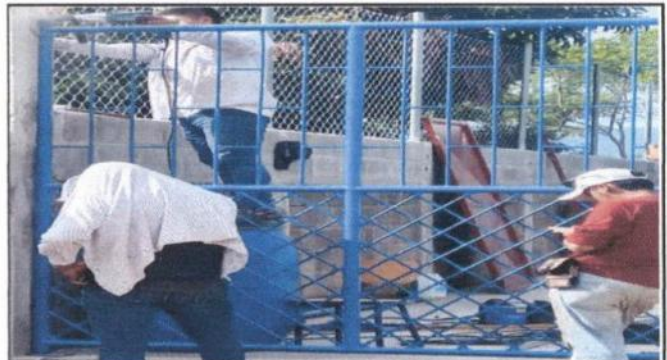
Foto 4: SUSTITUCIÓN DE PORTON
