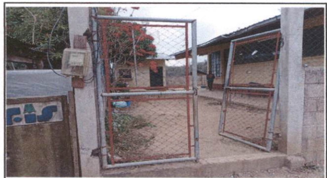
Foto 4: Sustitucion de portón
