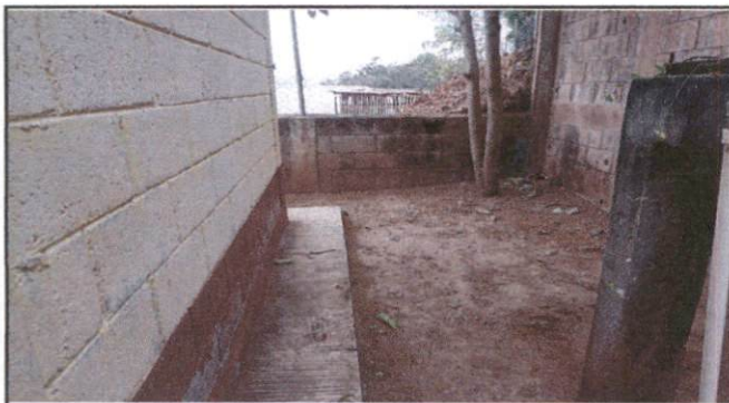
Foto 9: Funtición de losa de patio
