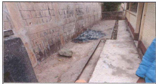
Foto 12: Reparacion de Losa de patio
