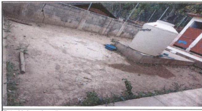
Foto 11: losa de patio
