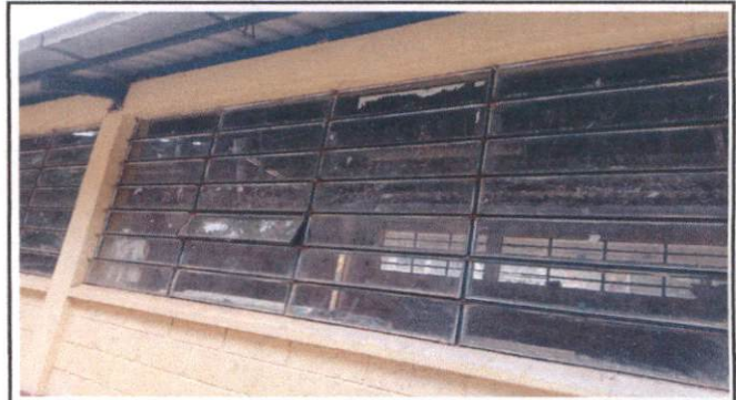
Foto 2: Sustitucion de ventana
