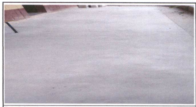
Foto 6: Instalacion de piso cerámica
