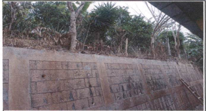
Foto 8: Reparación de muro, canales y bajada de agua pluvial
