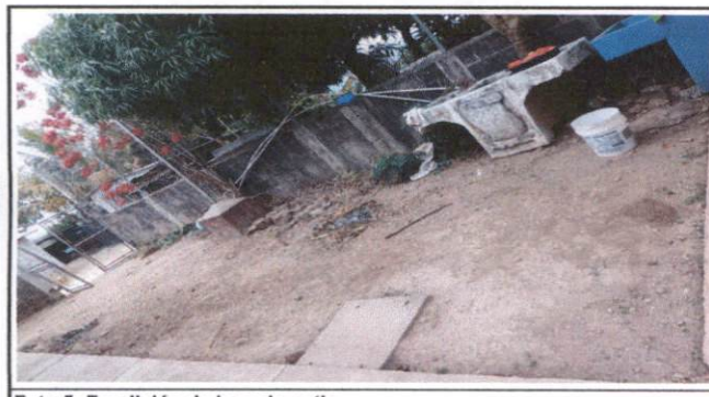
Foto 5: Fundición de losa de patio
