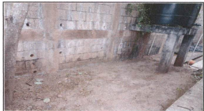
Foto 10: Losa de patio
