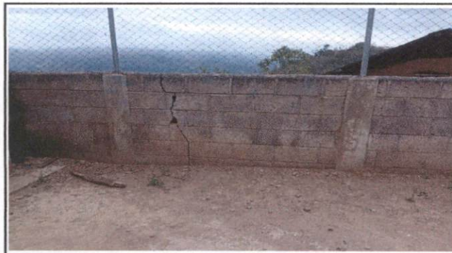
Foto 3: Reparacion de muro perimetral
