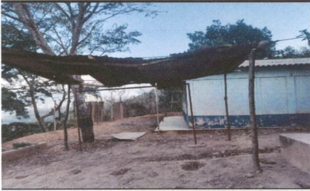
Foto 1: Cambio de estructura por lámina troquelada
