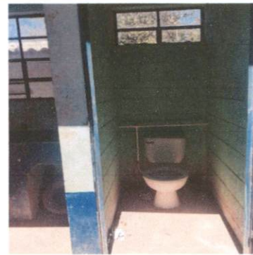
Foto 4: Reparación de puerta
