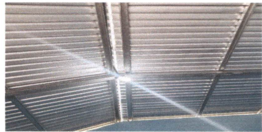
Foto 14: Reparación del sistema eléctrico.
