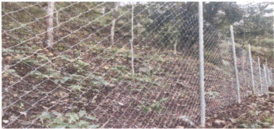
Foto 13: Reparación de muroperimetral de malla con tubo HG y malla.
