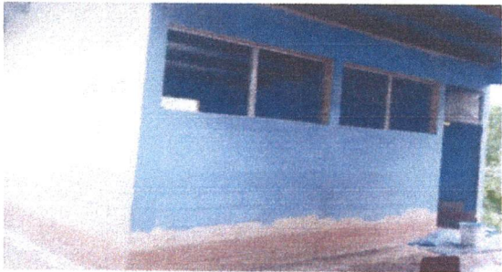
Foto 7 : Pintura de muros interiores y exteriores.
