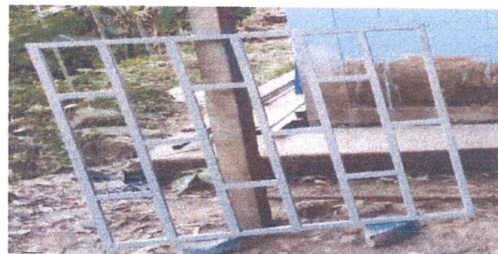
Foto 12: Instalación de barandas de metal.
