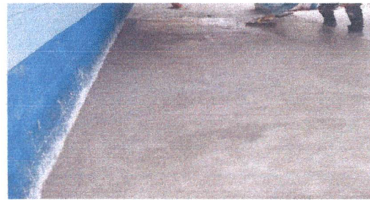
Foto 16: Reparación de piso de concreto.
