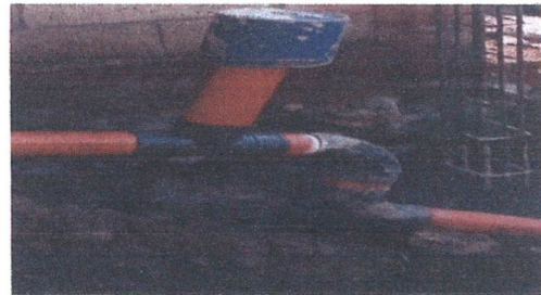
Foto 4: Reparación de red de drenajes y agua principal.
