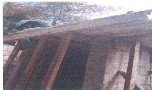
Foto 7: Reparación de muro de baño.
