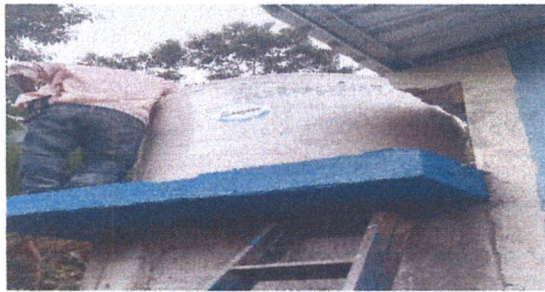
Foto 15: Instalación de sistema de depósito de agua y sus accesorios.
