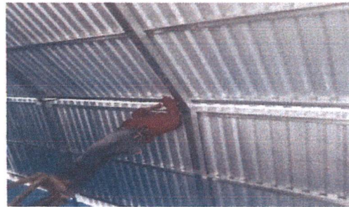
Foto 14: Reparación del sistema eléctrico.
