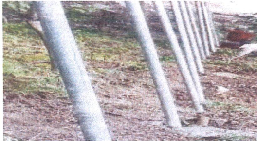
Foto 13: Reparación de muroperimetral de malla con tubo HG y malla.
