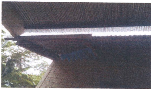
Foto 3: Reparación de bajada de agua pluvial de metal y tubo PVC 3.
