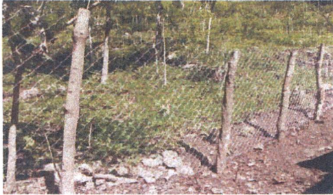
Foto 13: Reparación de muro perimetral de malla con tubo HG y malla.
