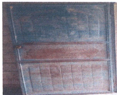
Foto 8: Mantenimiento a estructura de puerta ( Lijado y aplicación de pintura)
