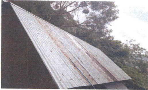
Foto 1: Sustitución de lámina, por lámina troquelada aluzinc calibre 26.
