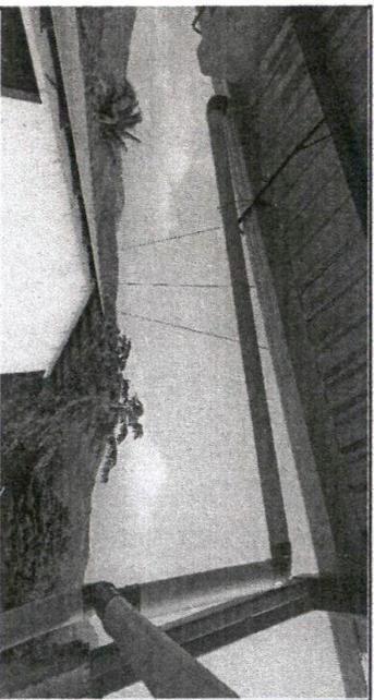
Foto 10: canales y bajadas de aguas pluviales
