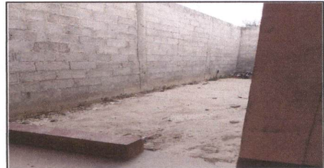
Foto 6: Losa de patio
