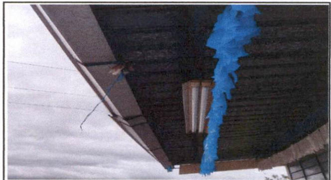
Foto 10: canales y bajadas de aguas pluviales
