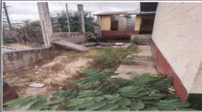
Foto 7: Losa de patio (atrás del aula 3)
