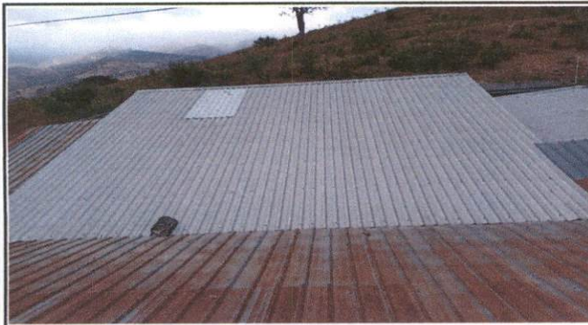
foto 3: Aula 2 cambio de techo
