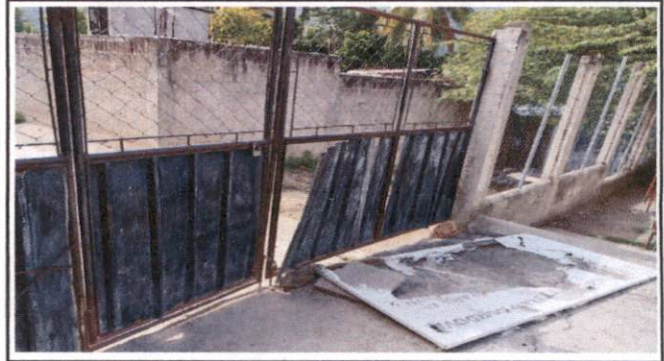
Foto 8: mantenimiento de Portón
