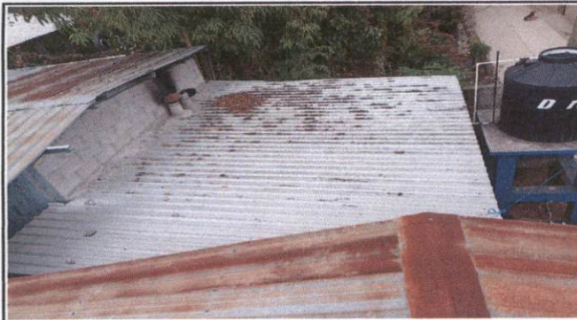
Foto 1: Cocina Cambio de techo
