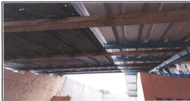
foto 5: Escenario Cambio de techo
