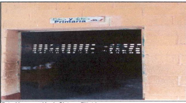
Foto 11: reparación de Sistema Eléctrico
