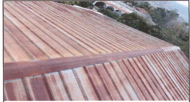
foto 4: Aula 3 cambio de techo
