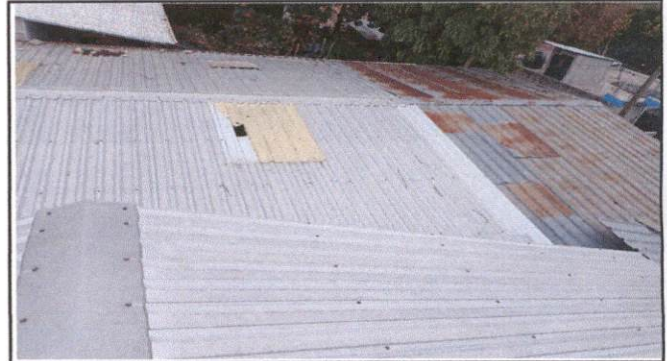
foto 2: Aula 1 cambio de techo
