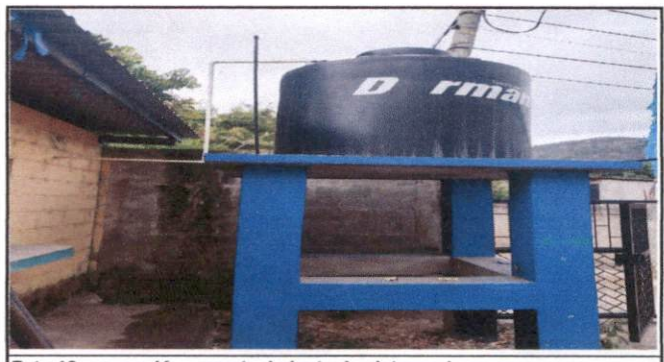
Foto 12: reparación y mantenimiento de sistema de agua
