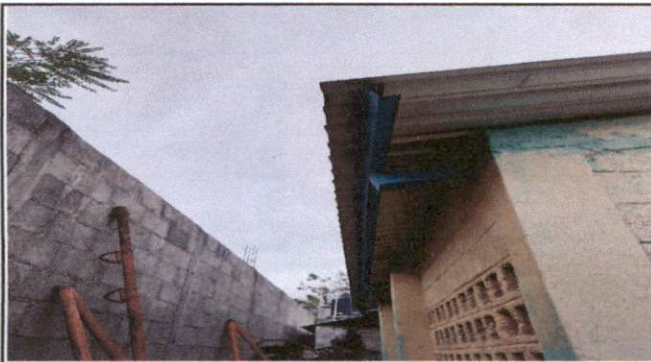
Foto 9: canales y bajadas de aguas pluvial
