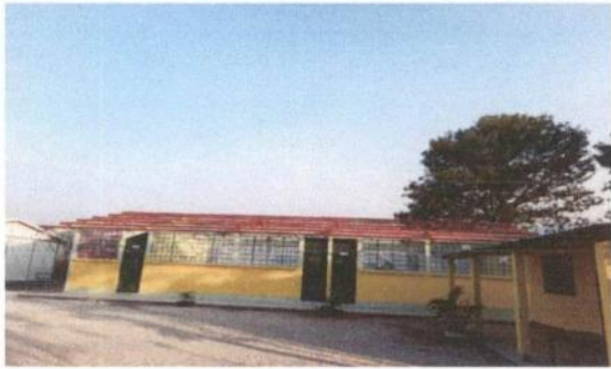
Cambio de techo y pintura
