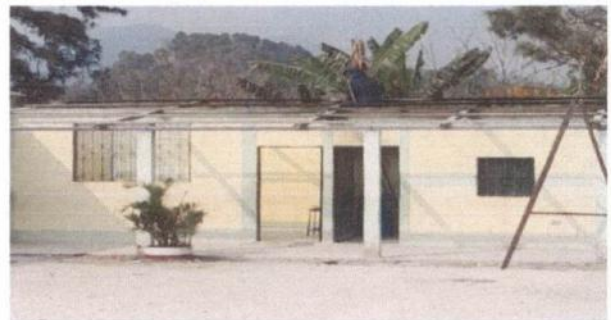
Cambio de techo, pintura y colocación de piso granito
