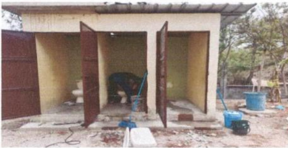
Reparación de puertas y sustitución de sanitarios.
