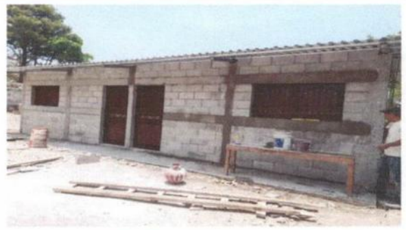
Cambio de techo, elaboración de puertas, ventanas y colocación de piso de granito.
