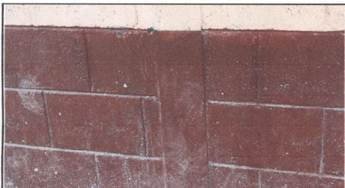
Foto 3: Pintura en muro exterior e interior
