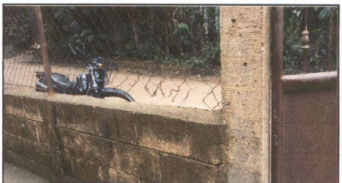
Foto 4: Reparación de muro perimetral
