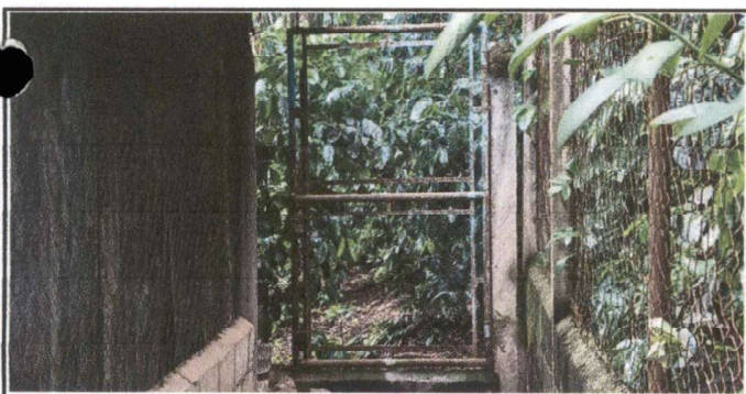
Foto 5: Sustitución de puerta
