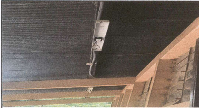
Foto1: Sustitución de lampara
