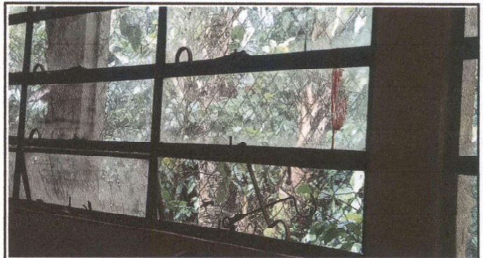
Foto 2: Sustitucion de balcon de vidrios por barandal
