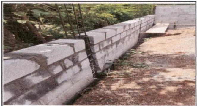
Foto 2: Sustrucción de muro perimetral
