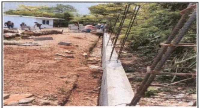
Foto 4: Sustrucción de muro perimetral
