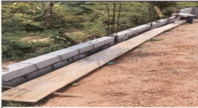
Foto 1: Sustrucción de muro perimetral
