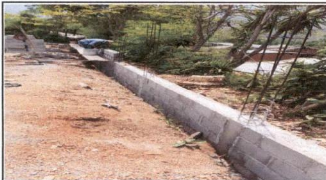
Foto 3: Sustrucción de muro perimetral
