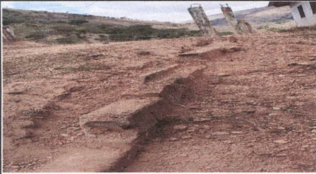
Foto 1: Sustrucion de muro perimetral
