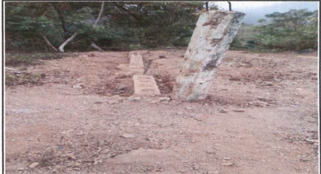
Foto 2: Sustrucion de muro perimetral
