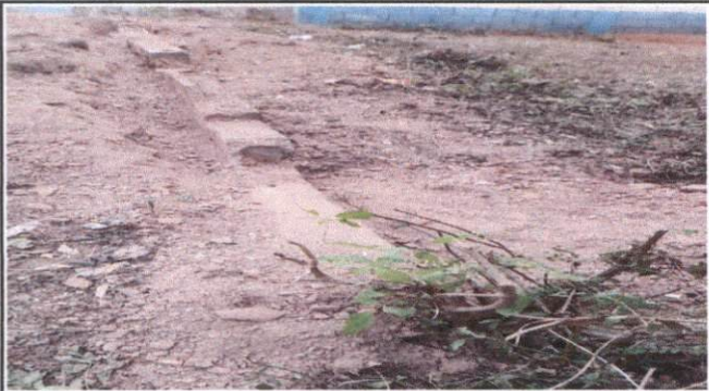
Foto 3: Sustrucion de muro perimetral
