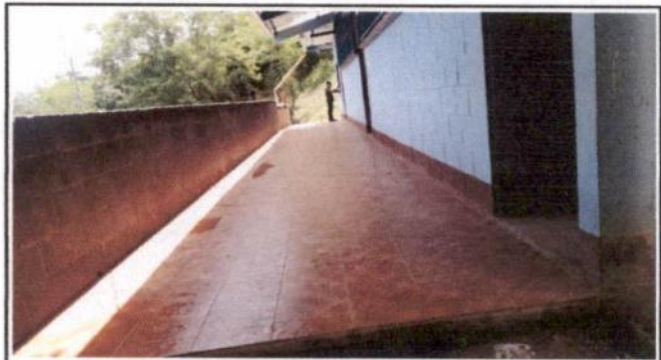
Foto 10: Instalación de piso ceramico
