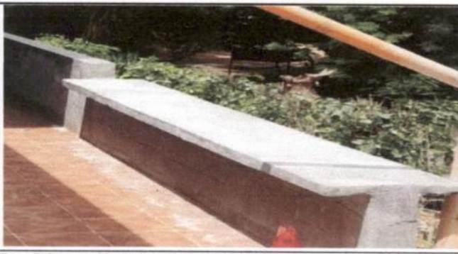
Foto 5: Reparación de repello de paredes
