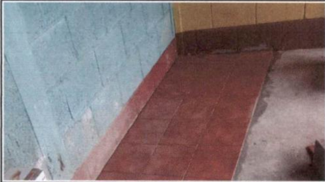
Foto 7: Instalación de piso ceramico
