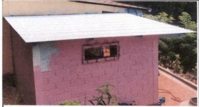
Foto 2: Cubierta de lamina de cocina
