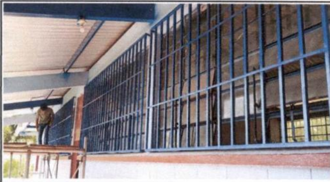
Foto 9: Instalación de baranda (balcon)
