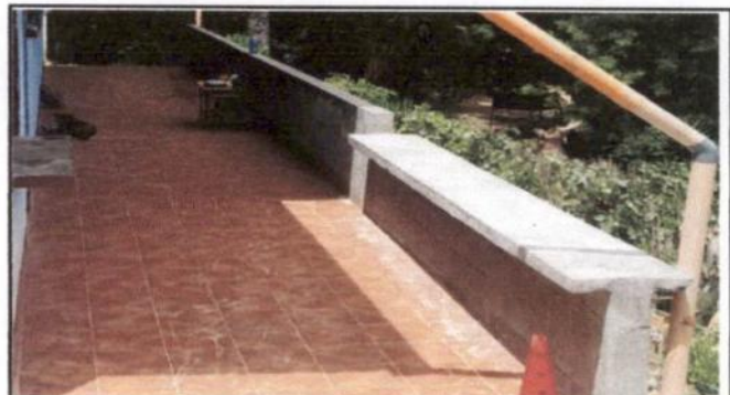
Foto 4: Reparación de muro de contención
