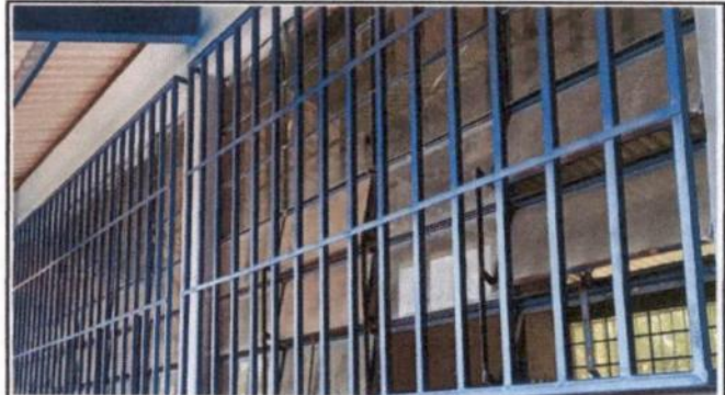
Foto 8: Mantenimiento de baranda
