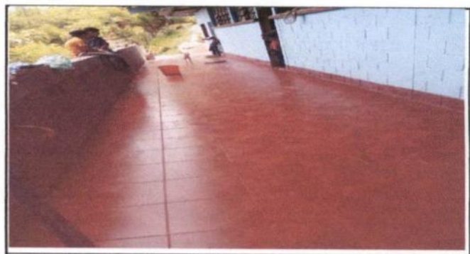
Foto 6: Reparación de losa de patio
