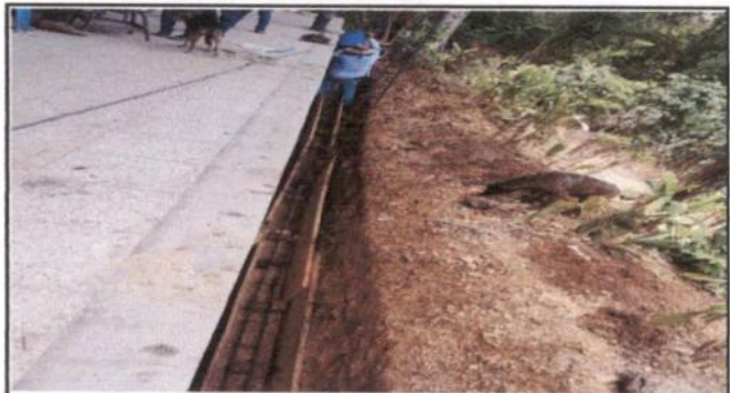
Foto 4: Reparación de muro de contención
