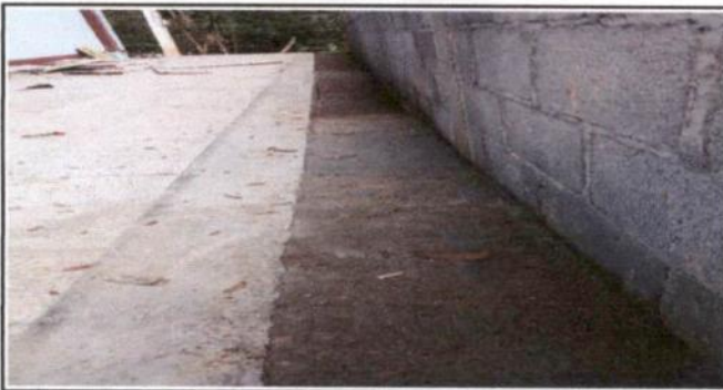
Foto 5: Reparación de repello de paredes
