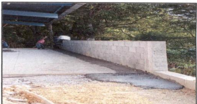
Foto 6: Reparación de losa de patio
