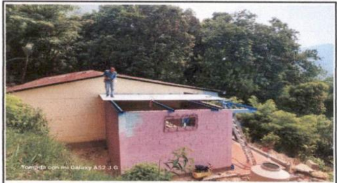
Foto 2: Cubierta de lamina de cocina
