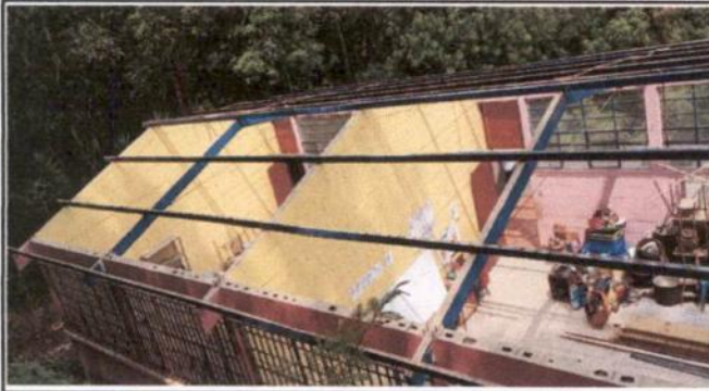
Foto1: Cubierta de lamina de aula
