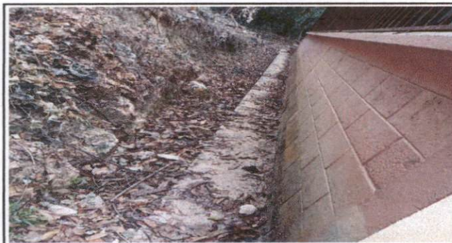
Foto 5: Reparación de Repello de paredes
