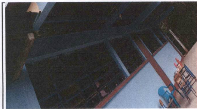
Foto 9: Instalación de baranda (balcon)
