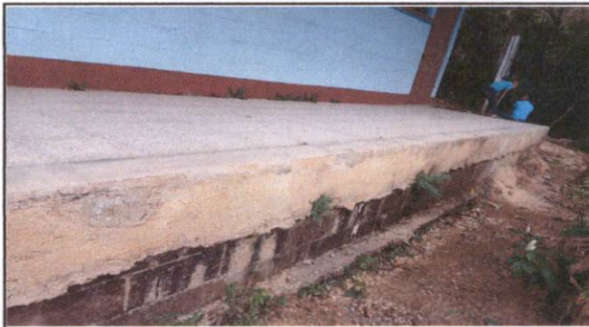
Foto 4: Reparación de muro de contención
