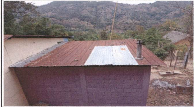
Foto 2: Cubierta de lamina cocina
