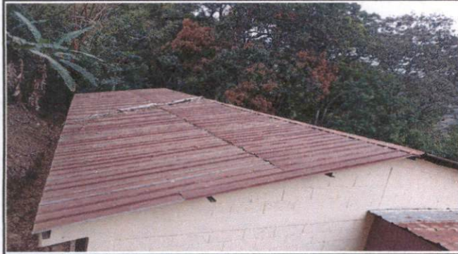
Foto 1: Cubierta de lamina Aula
