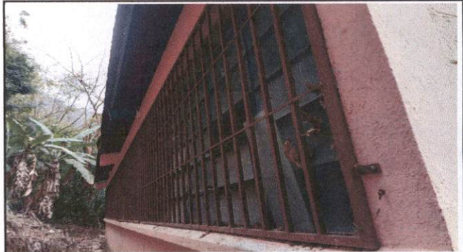
Foto 8: Mantenimiento de baranada (balcon)
