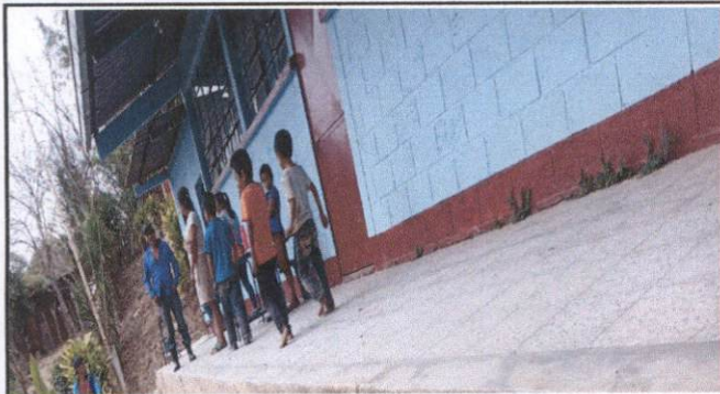
Foto 7: Instalación de piso cerámica de Granito
