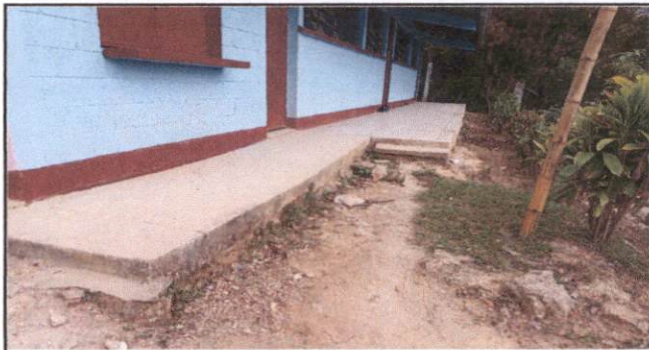
Foto 6: Reparacion de losa de patio
