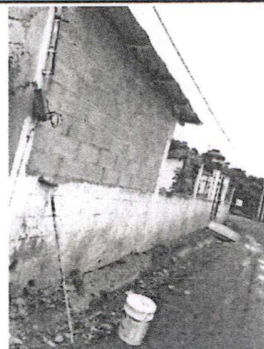
Foto 8: Reparación del muro perimetral
