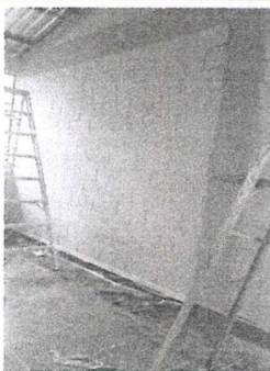
Foto 5: PINTURA EN INTERIORES DE AULAS
