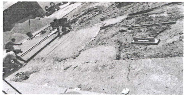
Foto 4: COLOCACIÓN DE LA LOSA DE CONCRETO EN EL PATIO
