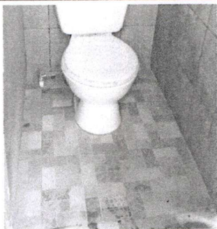
Foto 7: Reparación de baños
