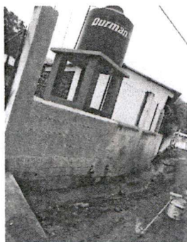
Foto 9: PINTURA DEL MURO PERIMETRAL
