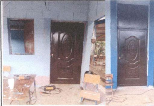
Foto 2: Mantenimiento de puertas (cepillado, lijado y pintado) y sustitución.
