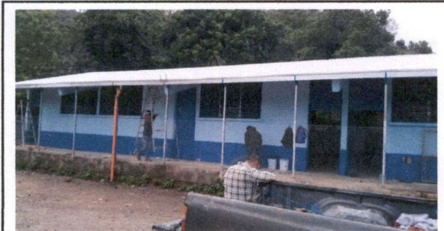
Foto 5: Colocación de canales y bajada pluvial.
