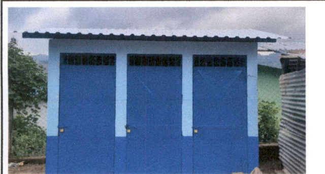
Foto 3: Remodelación completa de servicios sanitarios.
