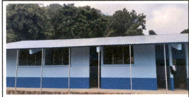
Foto 6: Cambio de techo y pintura de paredes.
