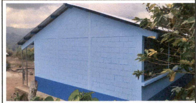
Foto 4: Pintura de paredes.
