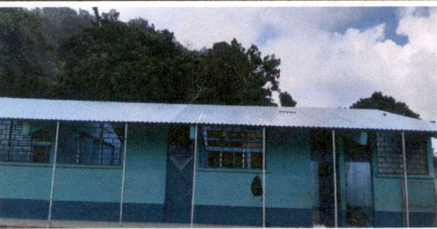
Foto 5: Se dió mantenimiento a soporte de techo y colocó el nuevo techo.
