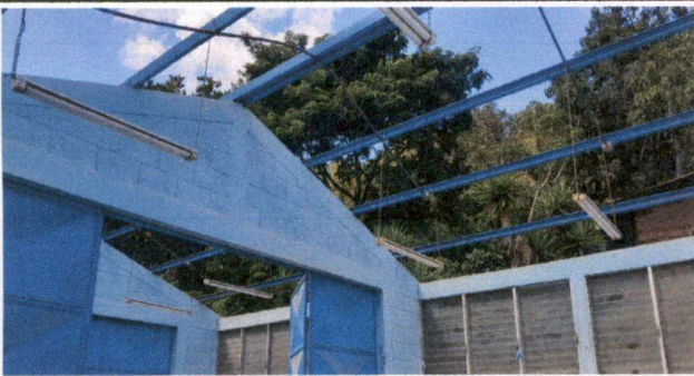
Foto 3: Se quitó el techo completo y se procedió a darle mantenimiento al soporte de techo.
