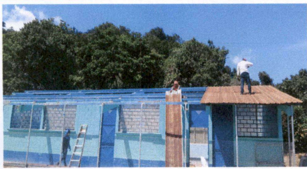
Foto1: Se está quitando el techo anterior, para posteriormente darle mantenimiento a la estructura de techo y colocación de nuevo techo.
