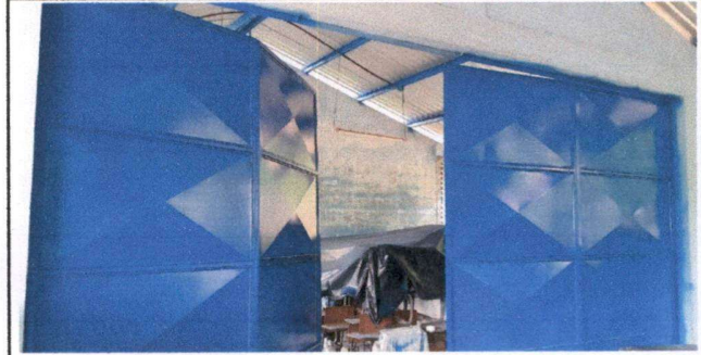
Foto 6: Mantenimiento de dos portones metálicos.
