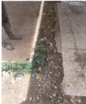
Foto 1: Sustitución de Tubería para agua pluvial.
