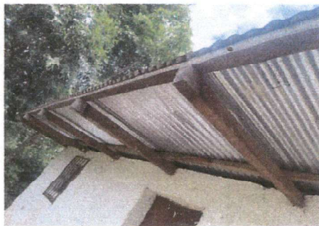
Foto 5: Sustitución de madera por estructura metálica.
