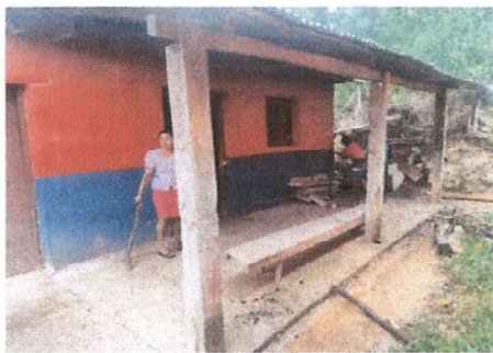
Foto 3: Reparación de columnas y torta de concreto de cocina.
