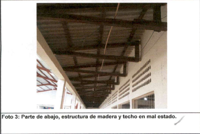
Foto 4: Parte de abajo, estructura de madera y techo en mal estado.
