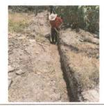
Foto 3: Limpieza del area en donde se encuentra el muro perimetral existente
