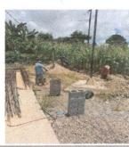
Foto 2: Armado de estribos los cuales sera utilizados para las columnas del muro
