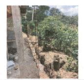
Foto1: . Armado de las columnas de refuerzo para el muro perimetral
