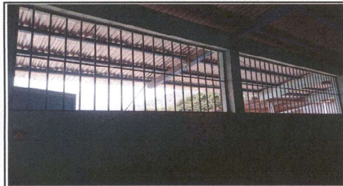
Foto 3: Sustitucion de ventana
