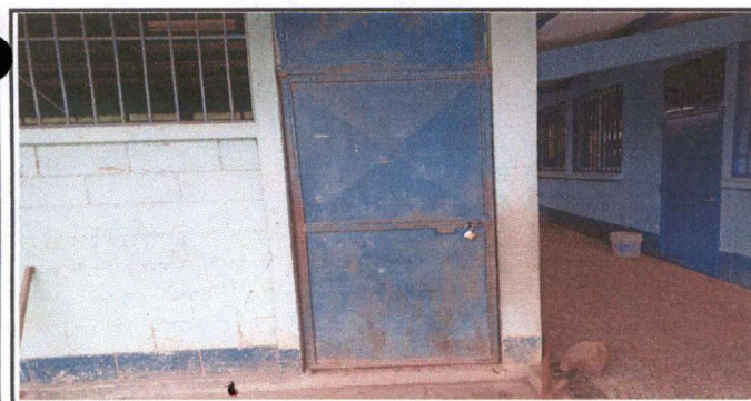
Foto 5: Sustitución de puerta antigua por puerta nueva de paneles aula
