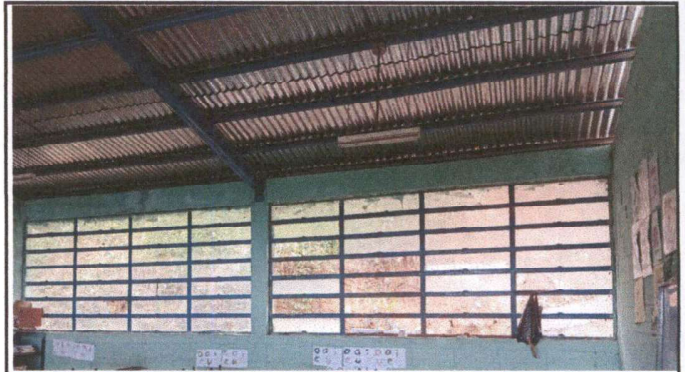
Foto 2: Sustitución de ventana de vidrio por ventana nueva de paneles
