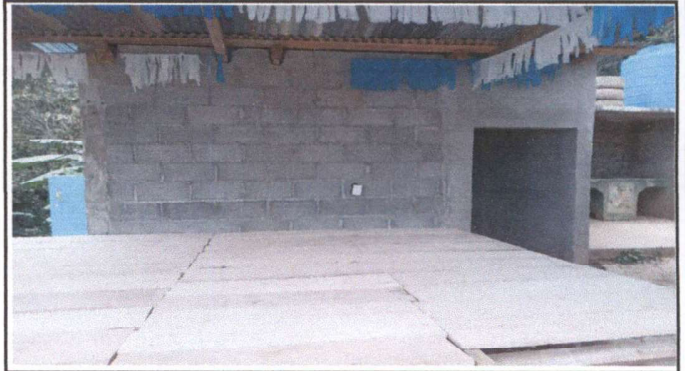
Foto 8: Instalación de puerta nueva de panel de la cocina
