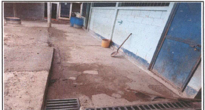
Foto 4: Sustitución de peso de concreto e instalación de piso ceramico corredor
