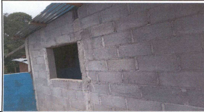
Foto 7: Instalación de ventana nueva de panel de la cocina
