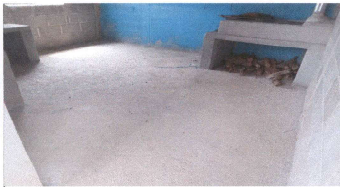
Foto 9: Instalación de piso cerámico de la cocina
