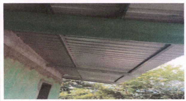
Foto 2: Estructuras y láminas nuevas.
