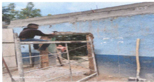
Foto 3: Ampleación del marco de la puerta.
