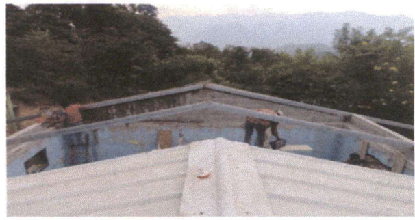
Foto 4: Instalación de estructura.
