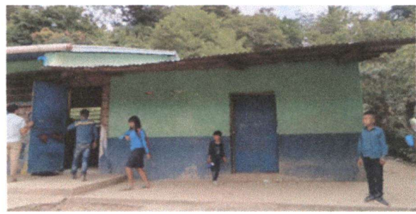
Foto 6: Sustitución de puerta de madera por metal.
