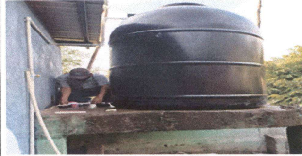
Foto 6: Sustitución del depósito de agua de 2,500 litros.
