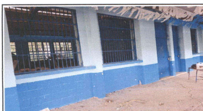
Foto 3: Sustitución de Balcones
