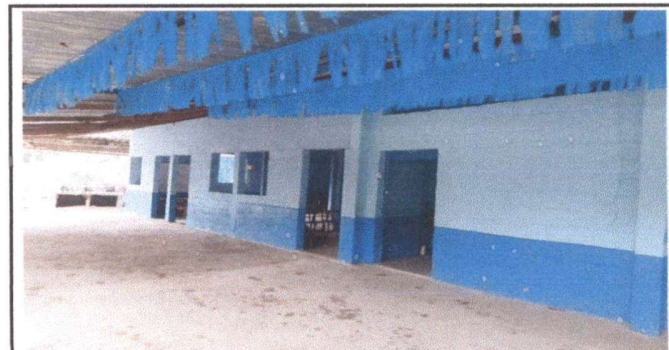
Foto 6: Reparación y seguimiento de levantada de muro perimetral
