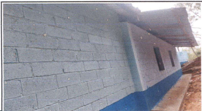
Foto 1: Reparación y seguimiento de levantado de muro perimetral
