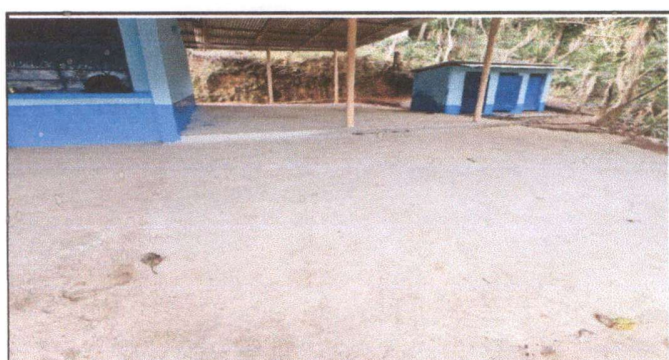
Foto 4: Fundición de losa de patio
