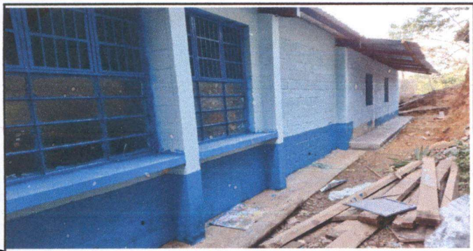
Foto 1: Reparación y seguimiento de levantado de muro perimetral
