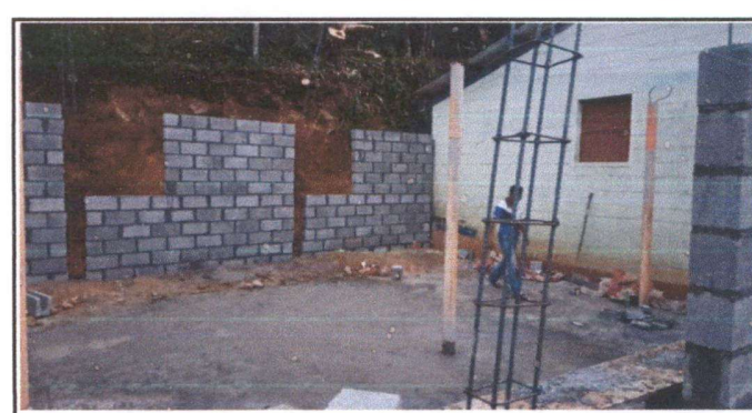
Foto 6: Reparación y seguimiento de levantada de muro perimetral
