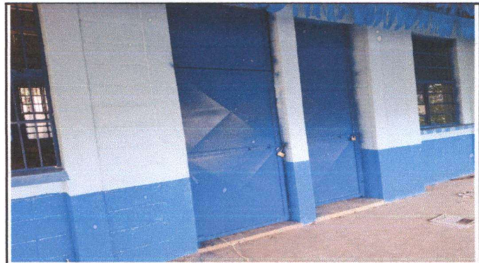
Foto 2: Pintura en muro exterior en inferior
