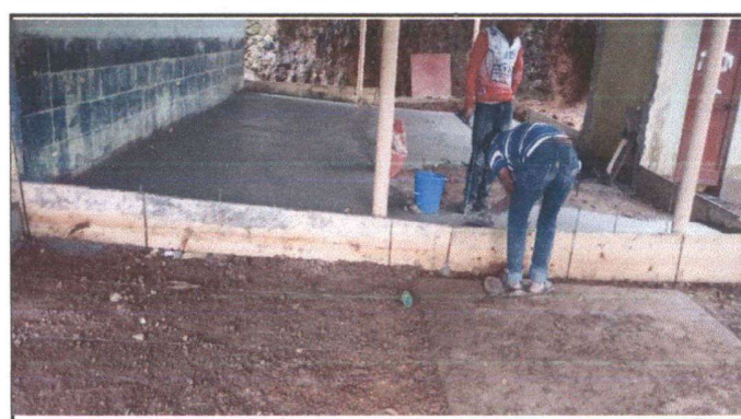
Foto 4: Fundición de losa de patio
