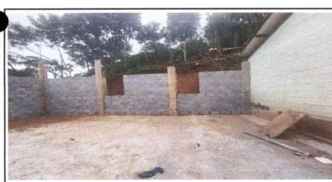
Foto 5: Reparación y seguimiento de levantada de muro perimetral
