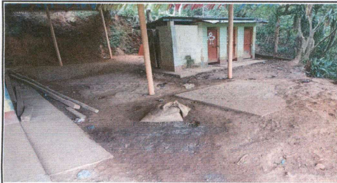
Foto 1: Fundición de losa de patio
