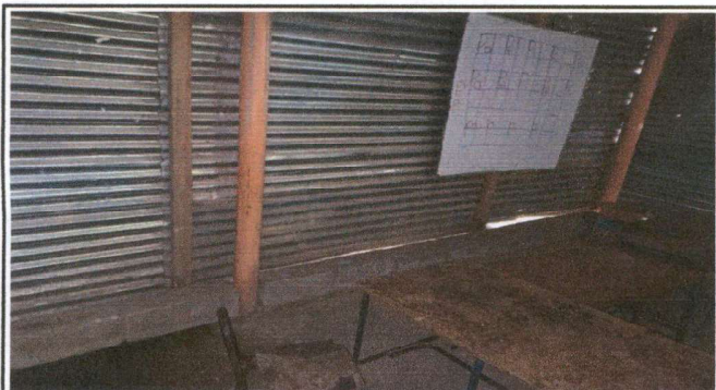
Foto 3: Reparación y seguimiento de levantada de muro perimetral
