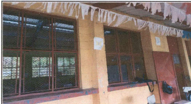
Foto 2: Sustitución de Balcones
