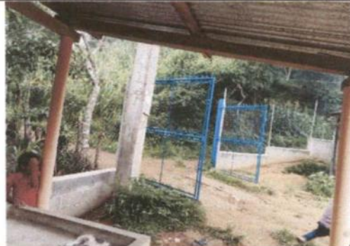
Foto 4: CIRCULADO CON BLOCK, MALLA Y TUBOS GALVANIZADOS PARTE FRONTAL Y PINTURA DE PORTON DE ENTRADA.
