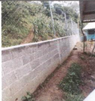
Foto 5: CONSTRUCCION DE MURO PERIMETRAL CON BLOCK, MALLA Y TUBOS GALVANIZADOS.
