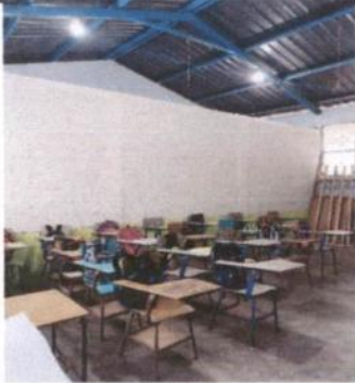
Foto 1: CONSTRUCCION DE PARED 1 PARA DIVISION DE AULA CON MURO PINTADO
