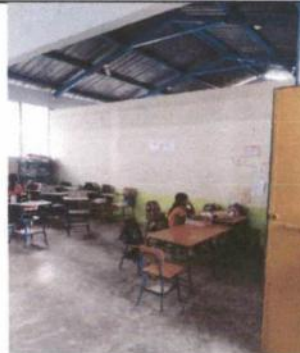
Foto 2: CONSTRUCCION DE PARED 2 PARA DIVISION DE AULA CON MURO PINTADO.
