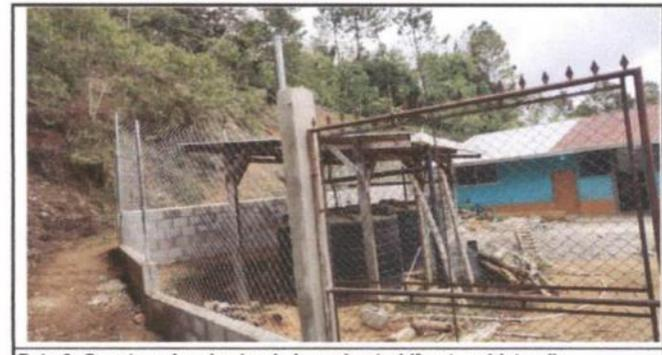
Foto 6: Construcción de circulado perimetral (frente y 1 lateral)
