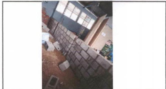
Foto 2: Avance de construcciones de paredes interiores para separación de aulas.
