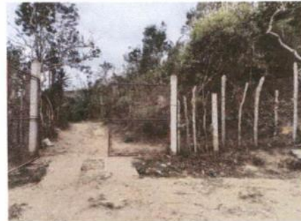
ASÍ SE ENCONTRABA EL CERCO PERIMETRAL Y EL PORTÓN DE ACCESO.
