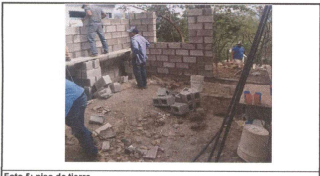
Foto 5: piso de tierra
