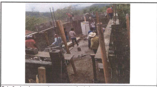
Foto 6: piso de concreto pero en mal estado.
