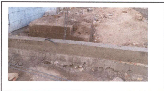
Foto 4: espacio a remozar, solamente estaban las bases.
