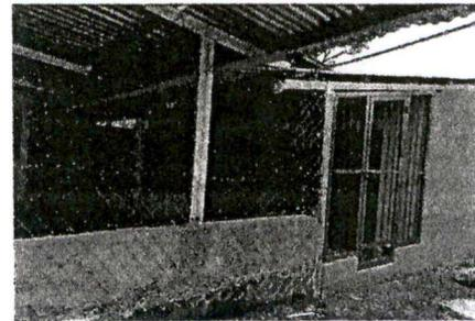
Foto 6: Reparación y mantenimiento de muro perimetral de block sobre el ya existente
