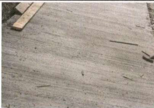
COLOCACIÓN DE TORTA DE CONCRETO
