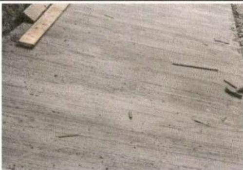
COLOCACIÓN DE TORTA DE CONCRETO
