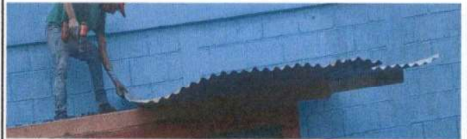
QUITADO DE LAMINA DE PILA
