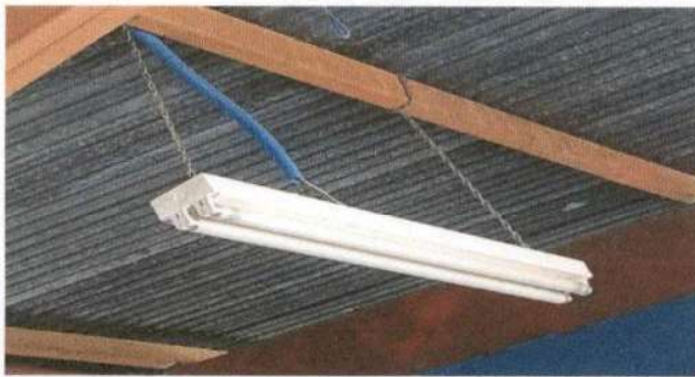
CAMBIO DE BARRA POR FOCO LED
