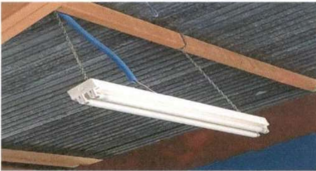
CAMBIO DE BARRA POR FOCO LED
